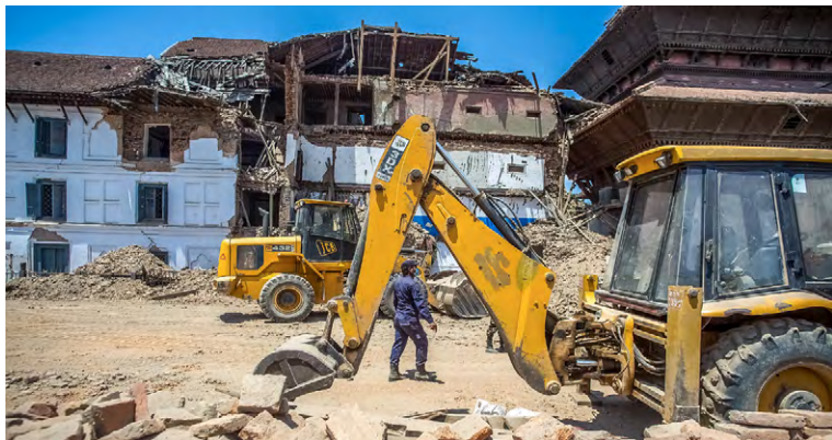
Odklízecí práce bezprostředně po zemětřesení v Káthmándú, Nepál, 2015. Foto: Tapash Paul/Drik.
