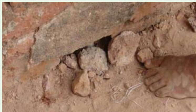
Díry v hydroizolačním systému střechy pagody v Baganu, Myanmar, 2016. Foto: Eugénie Crété.
